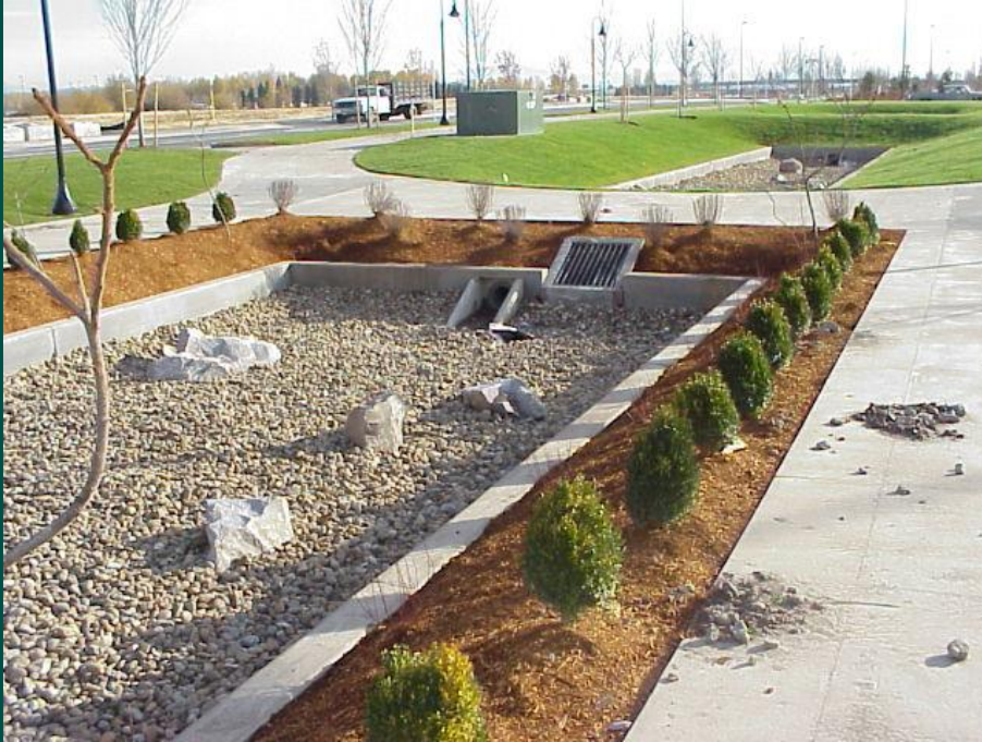
Estrutura de infiltração e armazenamento com filtro de areia e agregados
